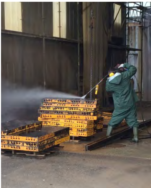
Figure 4 : Nettoyage des coffrages
